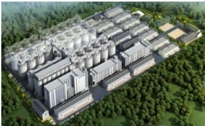
某中心粮库项目：本项目建设内容包括总仓容 18 万吨仓储设施、面粉应急加工车间、大米应急加工车间、烘干车间等，配套建设 1 座面粉低温成品仓、2 座大米低温成品仓，成品粮储备规模合计 1.72 万吨。公司承担该项目仓储、大米加工、
