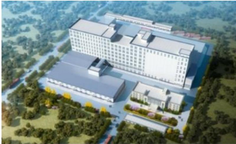
某面粉工厂项目：本项目建设内容为两条日处理小麦 500 吨专用面粉自动生产线，包括制粉车间、面粉库、麸皮库、麸皮打包车间等。项目排水实行“雨污分流、清污分流”，并选用低噪声设备，采取隔声减震、安装消声装置等措施减少对外环境的影响。建成后，其成品车间及麸皮车间将实现纯机械手码垛技术，极大节省人力资源。
