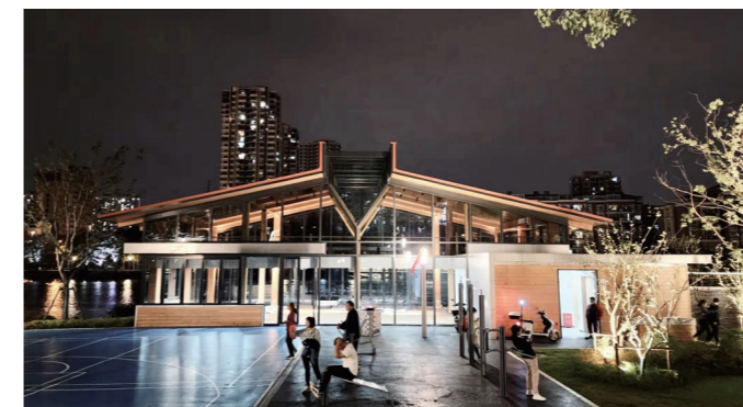
无锡梁溪河十里画廊青祁驿站（钢结构+ 胶合木结构）
