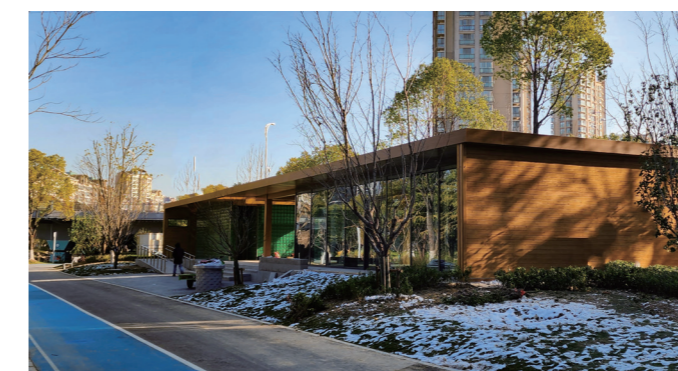
无锡梁溪河十里画廊鸿桥驿站（钢木混合结构）
