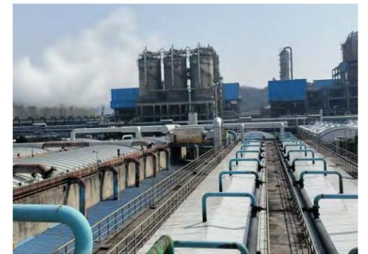
· 聚酯废气引入热煤炉焚烧后外排
