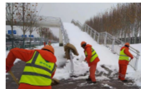
隧道股份城市运营开展除雪工作
