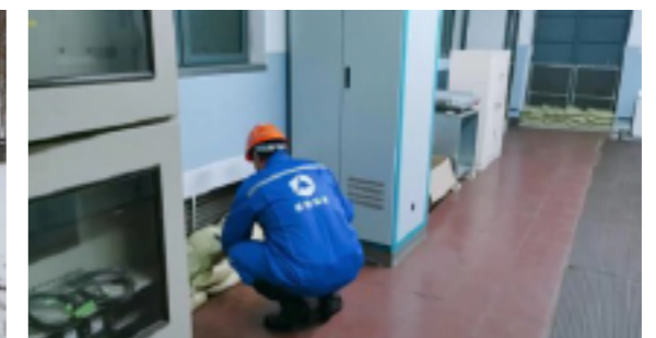
隧道股份城市运营执行巡检、排查及修复工作
