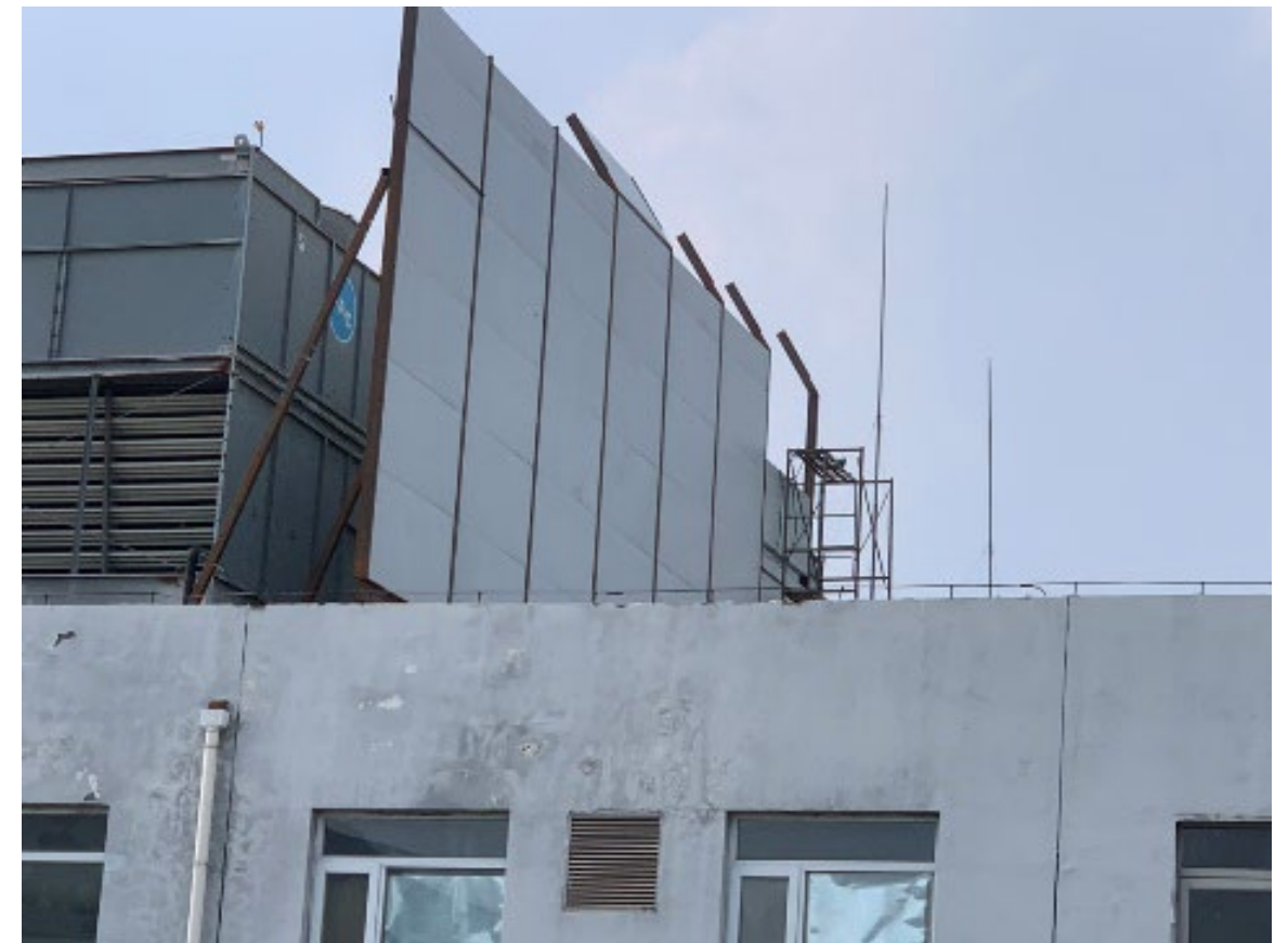
为噪音源设备安装隔音板
