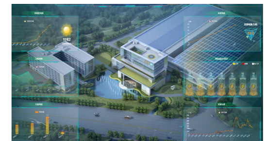
公司装备集团度山制造园区屋顶配备有太阳能光伏面板
