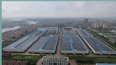
图 光伏项目整体情况
