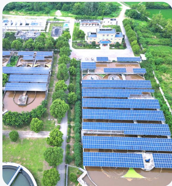
桐城城南污水厂光伏面板铺设图
