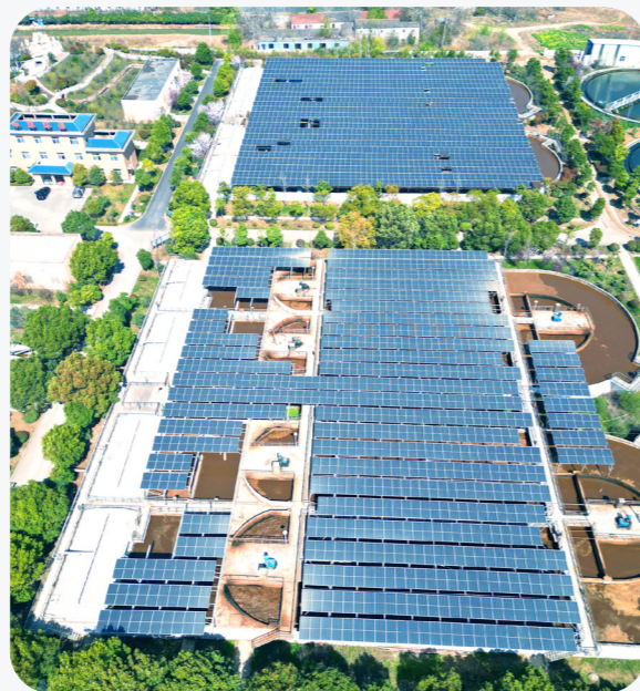
全椒污水厂光伏面板铺设图
