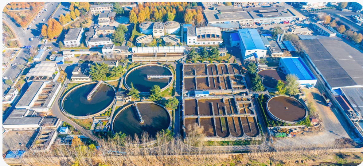
泰安第一污水处理厂
