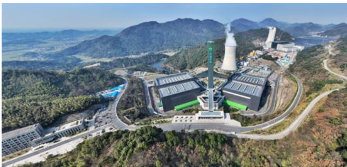
图 3 公司经营的长沙市城市固体废弃物处理场
