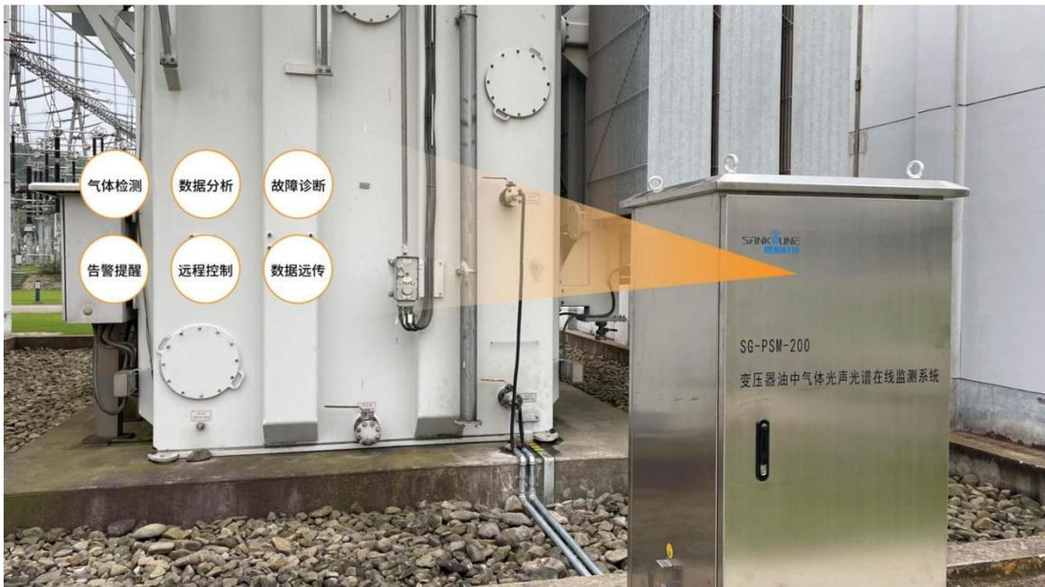
公司研发的变压器油中气体光声光谱在线监测系统是集控制、测量分析技术于一体的精密设备，主要用来在线监测变压器、电抗器等油浸式高压设备油中溶解的故障特征气体和溶解微水的含量及其增长率，并通过故障诊断专家系统早期预报设备隐患信息，避免设备事故，减少重大损失，提高设备运行的可靠性。该产品已经广泛应用于各电压等级变电站。
