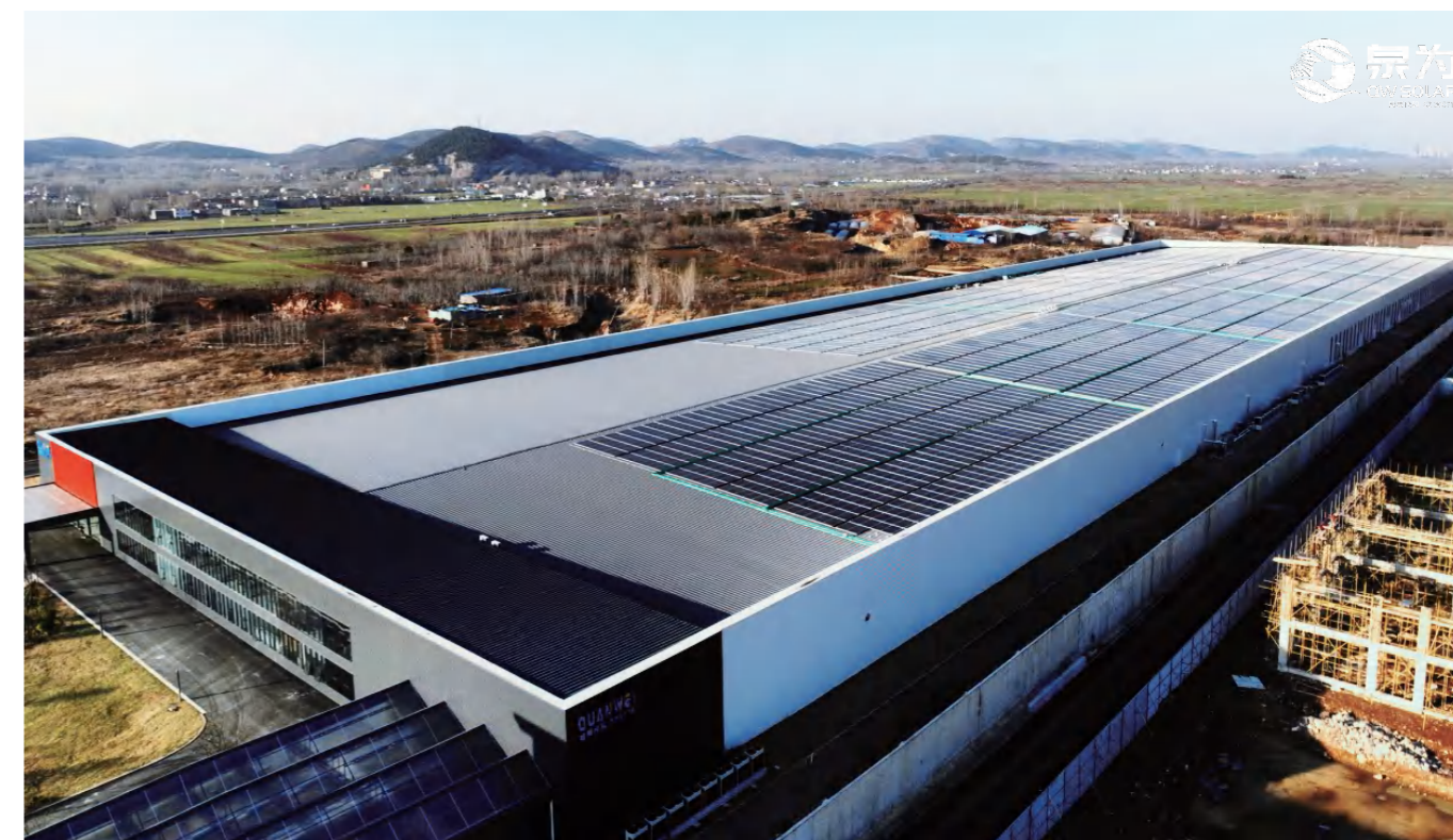
山东生产基地5.5MW屋面光伏项目外屋面
