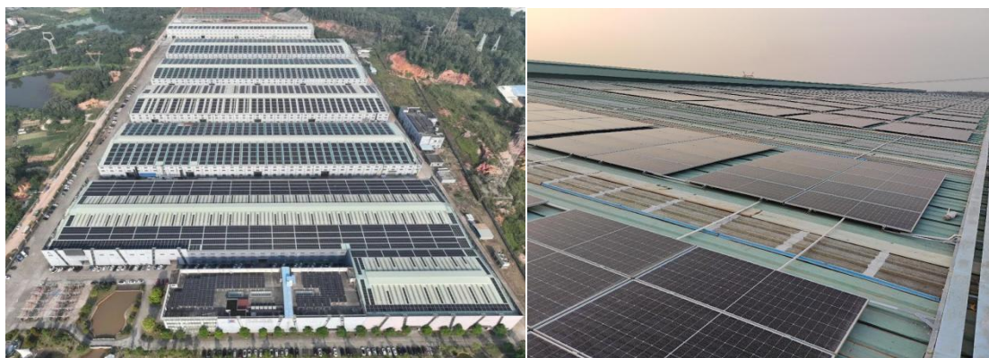
光伏项目实施现场
