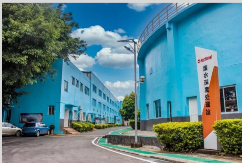
废水深度处理站
