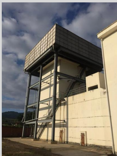
凡口矿率先完成全国首个通风井湿式 共振弦栅除尘净化系统
