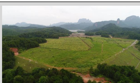
凡口矿尾矿库生态恢复
