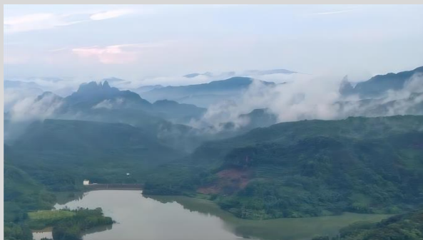
凡口铅锌矿尾矿库
