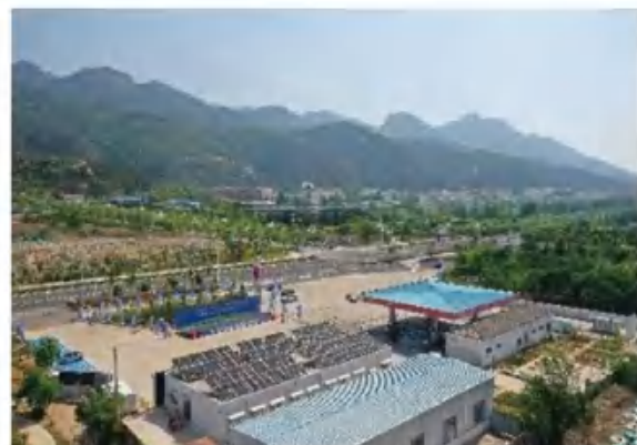
· 泰山石油光伏项目
