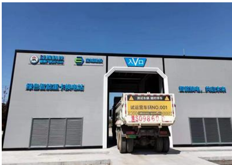
绿色智能重卡换电站建成投运
