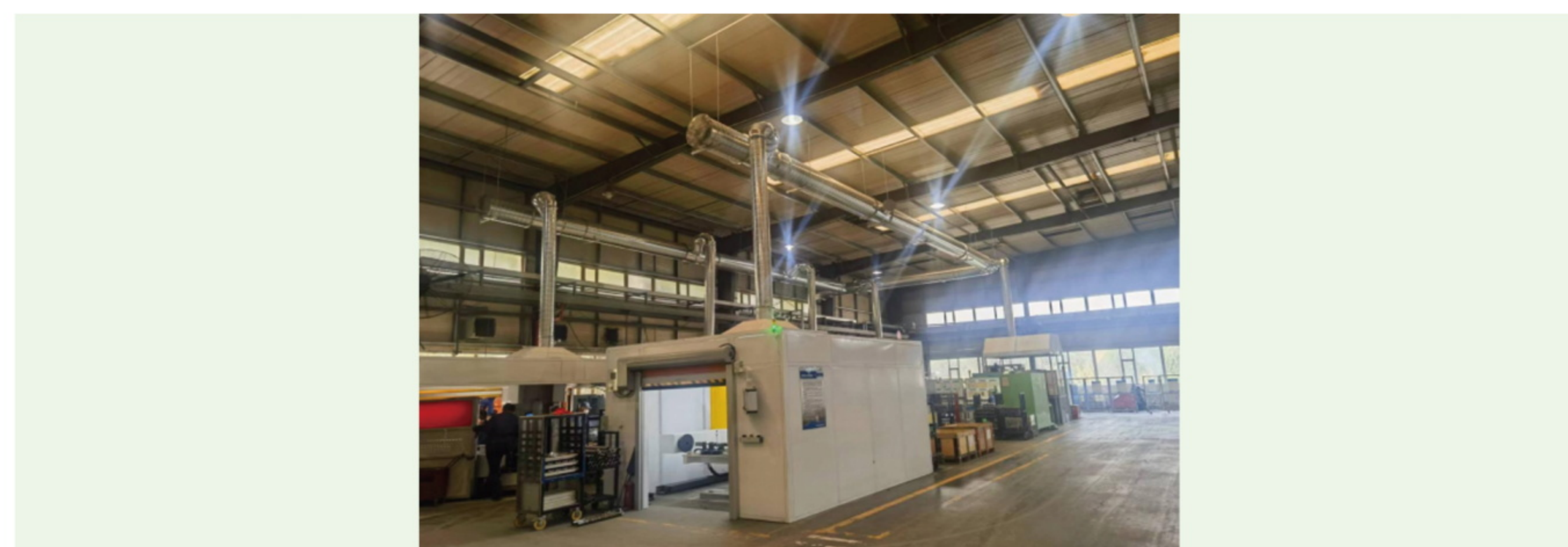
排烟除尘系统改造
