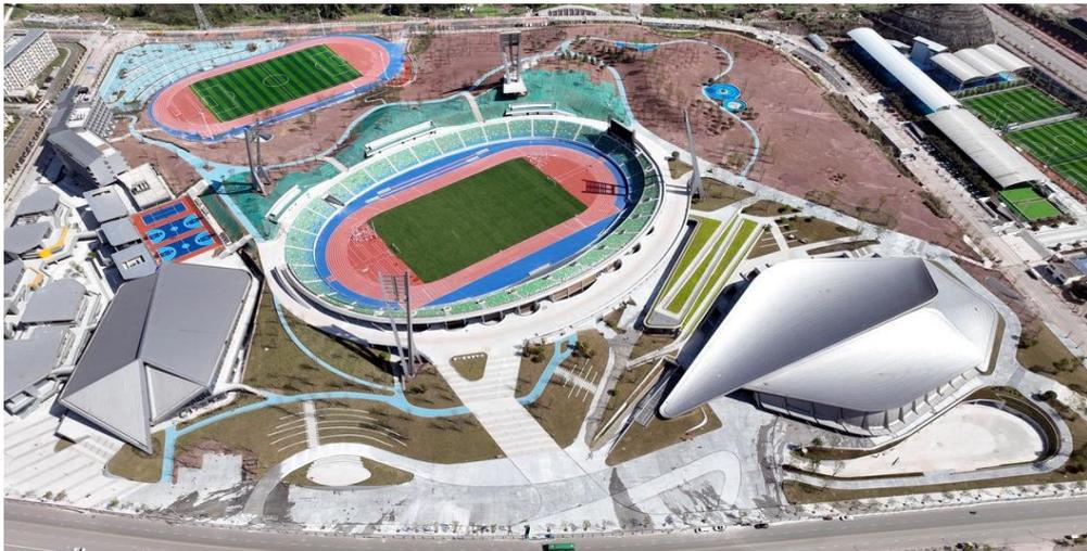
体育馆采用双曲面金属屋面系统和新型屋面结构体系，由 7288 块形状大小各异的金属板拼装而成，达到金属双曲屋面 6 毫米的内控精度要求。项目采用全流程 BIM 技术应用，结合装配式施工技术解决了体育场馆大型双曲异形幕墙、超大弧形拉网板及马道弧形铝板变形与工期问题。有效保证了拉网板和铝板安装质量和外观美观的效果；将“一场两馆”的惊艳之姿呈现在世人眼前。
