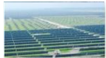
国家光伏·储能实证实验平台 (大庆基地)一期工程项目
