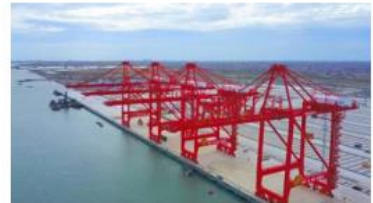
| 启东港区吕四作业区内河转运码头一期
