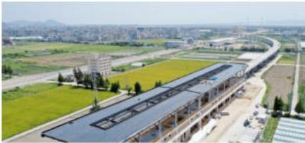
| 温州市域铁路S2线一期工程
