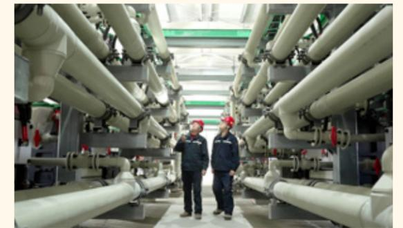
工作人员正在巡视检查电池堆及电解液循环系统
