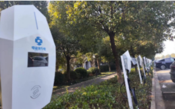
新能源汽车充电桩
