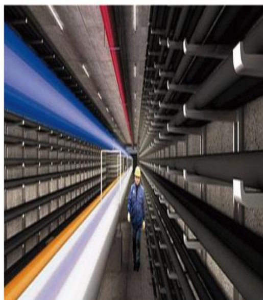
江北综合管廊基坑监测
