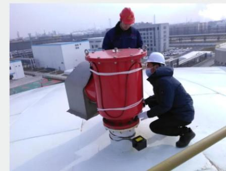
在无组织VOCs的逸散管控上，公司严格按照《关于加强连云港石化基地内企业挥发性有机液体常压储罐呼吸阀和紧急泄压阀无组织排放管控的通知》要求，对罐区储罐呼吸阀、泄放阀进行提升更换，共计更换环保型呼吸阀118台，更换后呼吸阀泄漏量由国标要求的0.4m<sup>3</sup>/h下降至欧标要求的0.003m<sup>3</sup>/h，泄漏量大幅减少。
