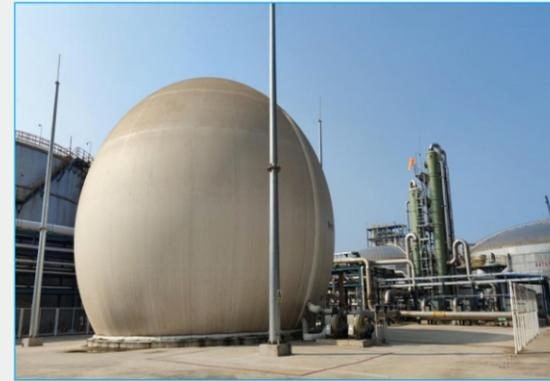
斯尔邦石化针对SAR装置冷凝污水COD含量高的特点，采用高效厌氧反应器进行污水处理，在高效降解COD的同时副产沼气，沼气回收替代天然气燃料，实现了环境效益的双赢，助力企业做好碳达峰、碳中和工作，向绿色、低碳、循环、生态化、可持续化方向发展。经统计，2023年度回收利用沼气约188.95万Nm<sup>3</sup>。
