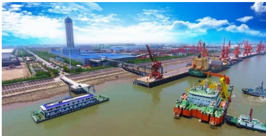
图 23 国家电网舟山项目
