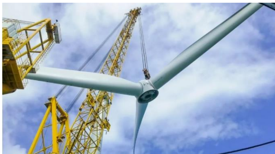
图 5 亨通浙能台州 1 号海上风电项目风机安装工程
