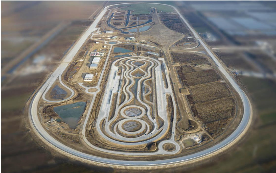
长三角（盐城）智能网联汽车试验场建设全景图
