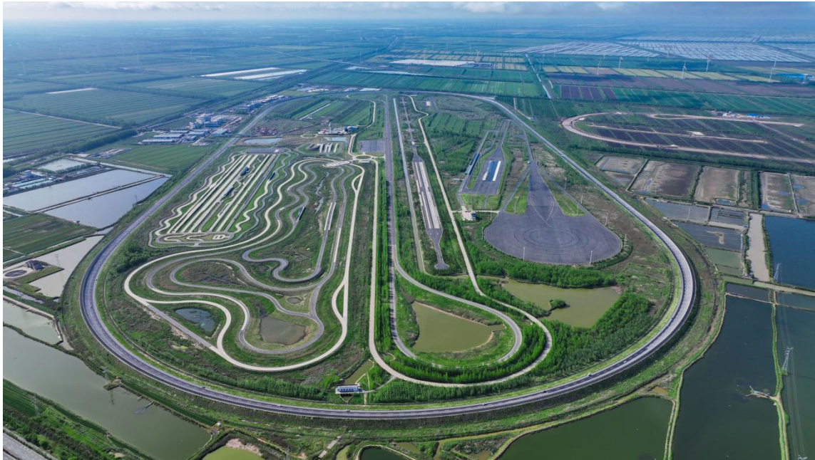
中汽股份综合汽车试验场全景图
