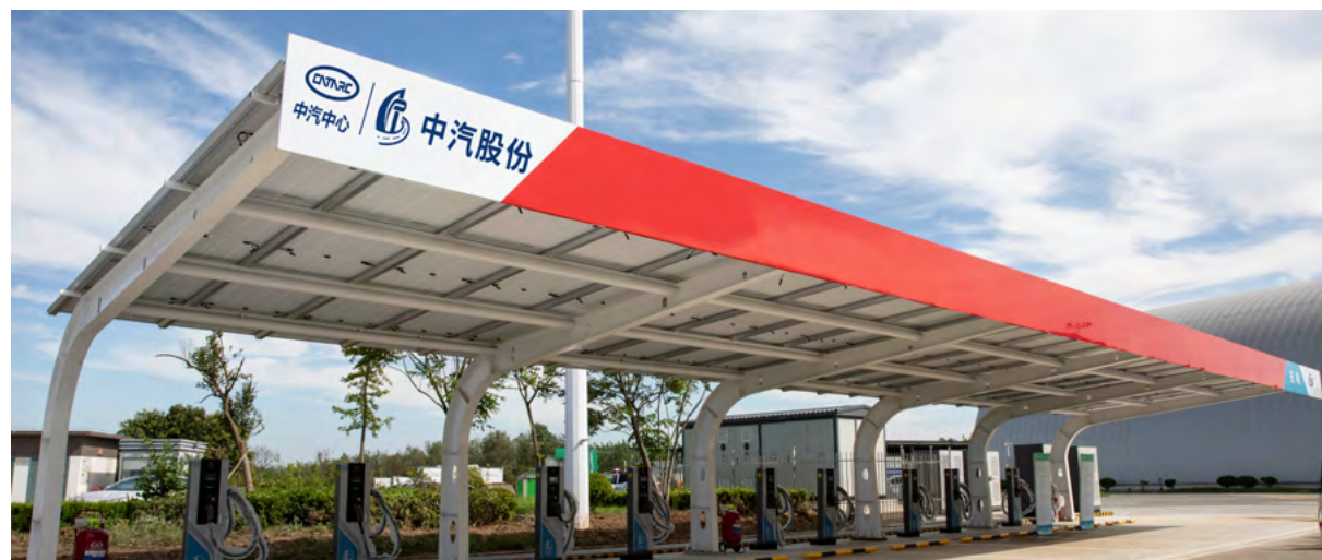
“光、储、充一体化”新能源汽车超级充电站
