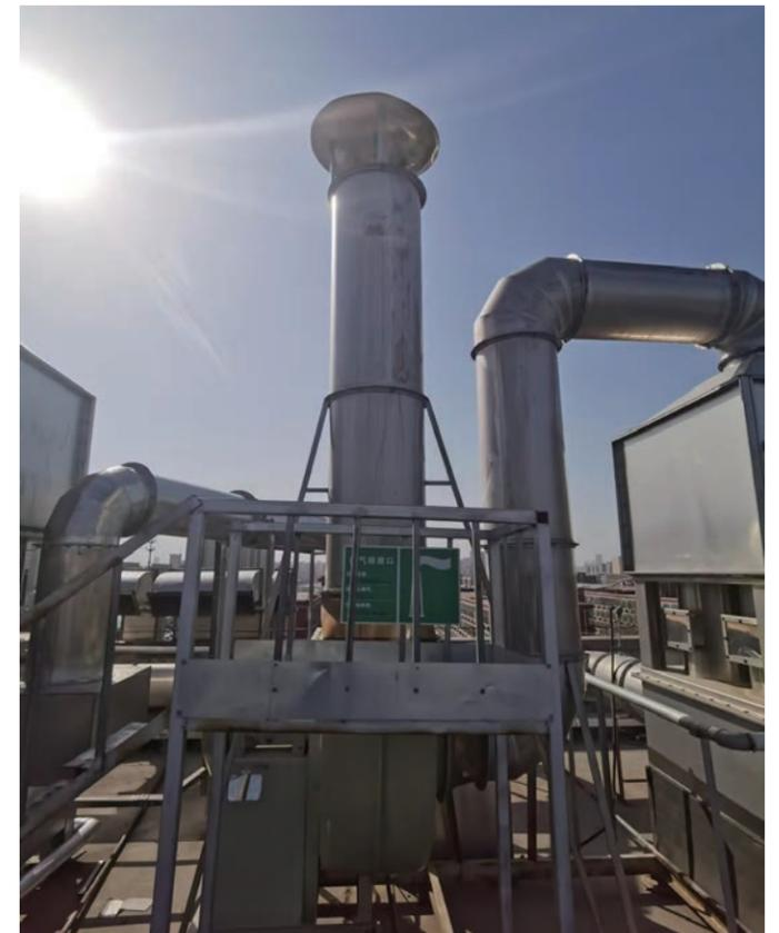
2023 年 6 月，以岭万洲国际对制剂二车间元成流化床干燥废气进行提标治理，投资 34 万元新增一套二级水喷淋废气治理设施，提升对干燥废气中颗粒物及非甲烷总烃的治理效率。
