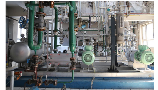
乙腈装置 VOCs 改用水环真空机组项目
