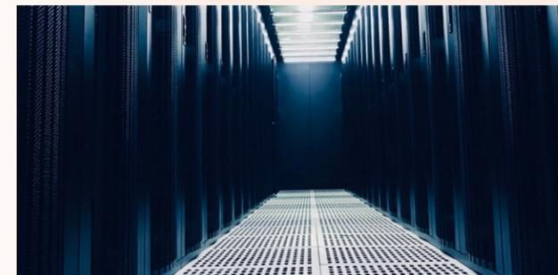
机房冷风通道更换为可调节通风地板，调整负载较小机柜送风量，对机柜进行精准送风，减少能源消耗。
