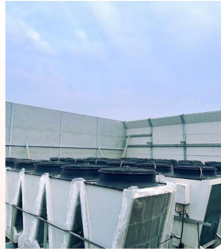
微雾机组树脂罐生成软化水，通过高压喷头进行雾状喷洒，提高夏季高负荷运作时空调降温效率，有效减少安全风险。
