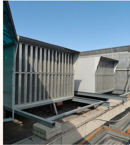
4 台空调采用 Freecooling 机组通过冬季冷空气对空调机组降温，减少空调机组压缩机数量。
