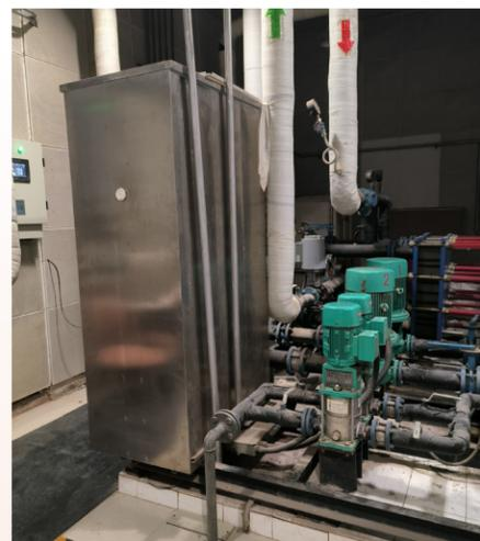
热力自管站通过温度及使用时间，对换热设备设定点进行分时段调整，在保障供暖效果的同时降低能耗，每年可减少约 772.17GJ 热力供应。
