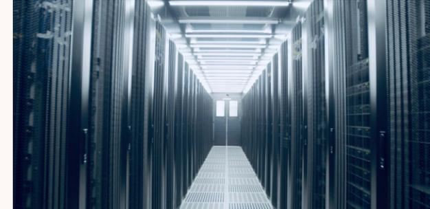
冷风通道增加导流风机，调整局部风量，减少空调送风口对机柜布局的冷热分配不均影响，降低数据中心最低温度设定要求。
