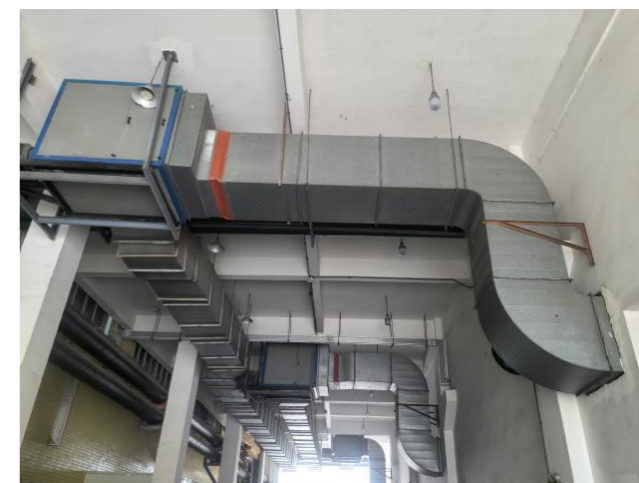
废气处理设备
