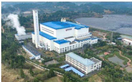
垃圾焚烧发电厂
