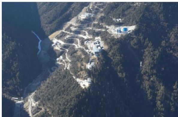
矿山项目全景
