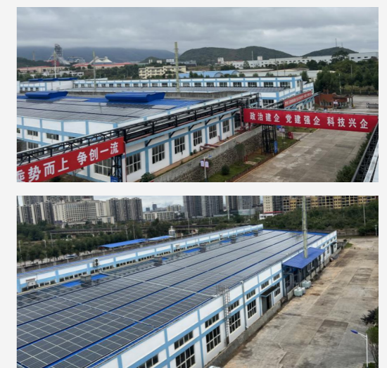
▲ 中稀永州新材光伏发电项目
