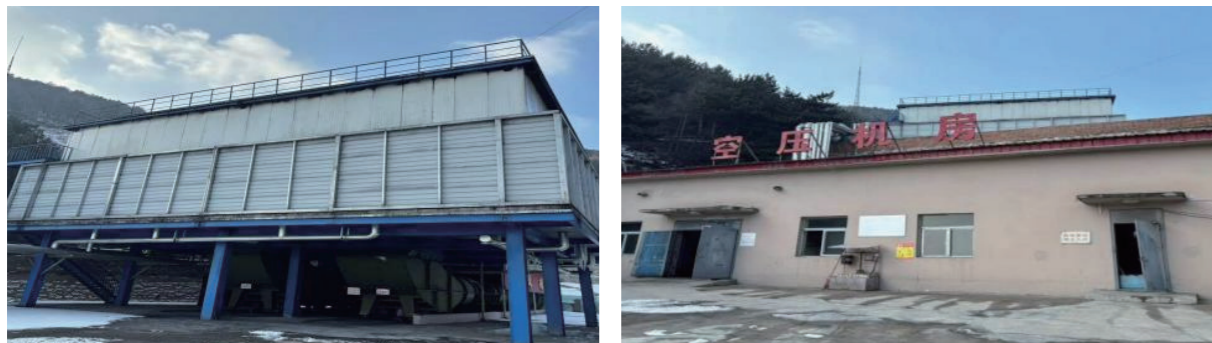
▲ 锦辉煤业乏风取热机和空压机房
