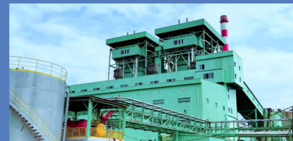
印尼杜迈金鹰 SDS2 自备电厂 EPC 项目
