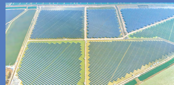
江苏连云港云台 50MW 地面光伏发电项目
