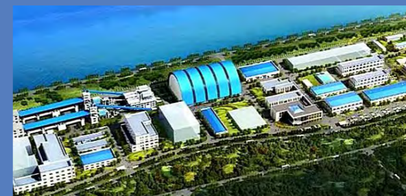
印尼锂盐 2*50T/H 燃煤锅炉 EPC 项目
