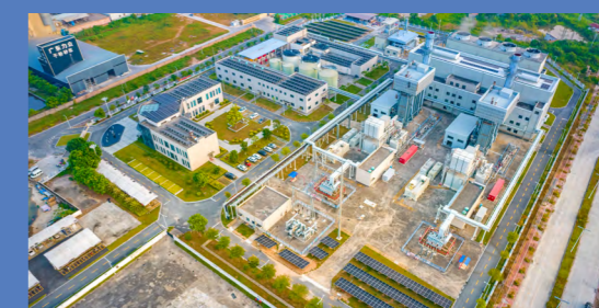
高州燃机项目
