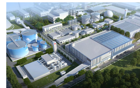
华士镇中心污水处理厂及污水治理设施提升工程（EPC）项目
