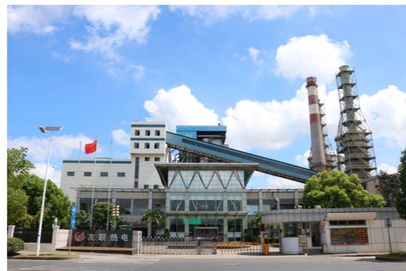
友联热电开展余热回收储能提效项目
