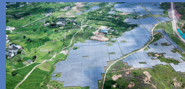
江西赣州市于都仁风 40MW 地面光伏发电项目
