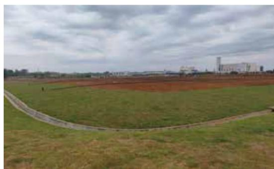
项目封场投影面积为 7.3 万平方米，其中封场区域投影面积为 6 万平方米。工程包括填埋堆体整形、封场覆盖工程、雨水导排工程、填埋气体收集导排工程、渗滤液收集导排工程、巡视道路工程等相关配套工程。
