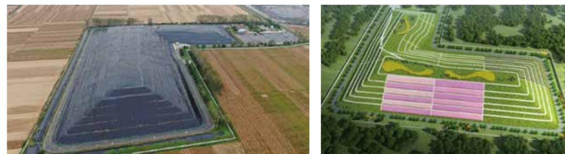
漯河市垃圾填埋场一、二、三期填埋区进行生态封场，封场工程主要包括：堆体整形、渗滤液收集、导气、覆盖、绿化等
