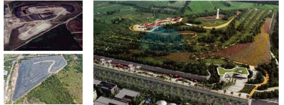
颜春岭垃圾填埋场于 2001 年 5 月建成投入使用，填埋区总占地面积 319.5 亩，设计总库容 303.74 万立方米，设计使用年限 10 年，最终使用 20 年，填埋场总库容已达到 450.43 万立方米，长期处于超设计规模运行状态。本次项目建设主要包括：垂直防渗帷幕管控体系、堆体治理工程、飞灰转运工程、超容垃圾外运焚烧发电处置工程、剩余垃圾规范化封场工程、专项工程等相关工程方案设计、初步设计、施工图设计及相关服务、施工总承包。
