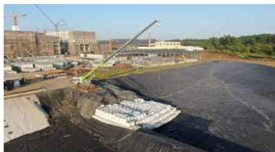
飞灰填埋场的库容 29 万立方米，飞灰稳定化物最大填埋量约 145 吨 / 天，主要内容为飞灰稳定化物填埋场调试配合和填埋场运行维护。
