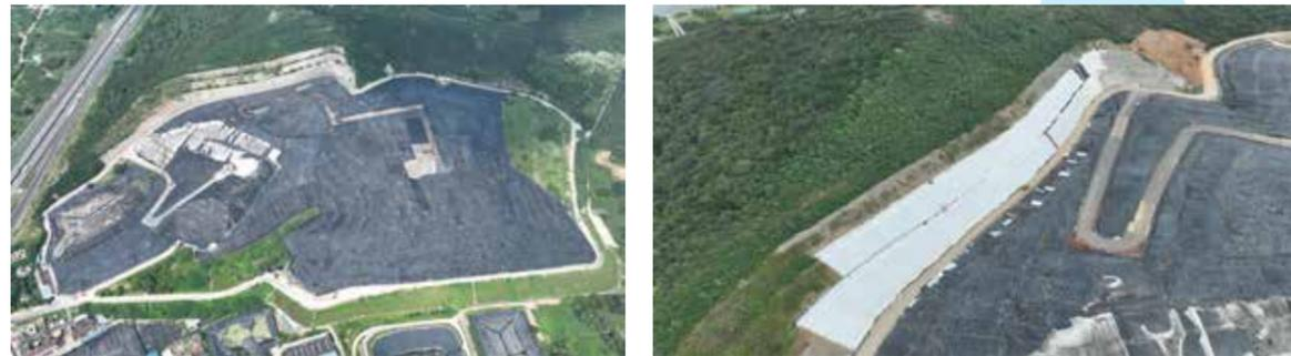
工程建设内容包括封场覆盖区域及新建库区防渗膜铺贴、渗滤液导排系统、填埋气收集系统、地下水导排系统的管道铺设。
