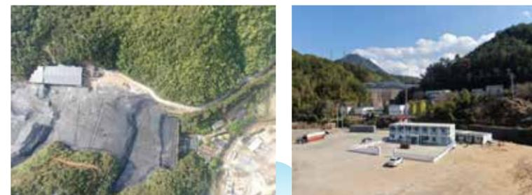
项目服务内容包括庆元县生活垃圾填埋场 32.8 万立方米（39.36 万 t）陈腐垃圾开挖、筛分、转运、处置及渗滤液处置等。
