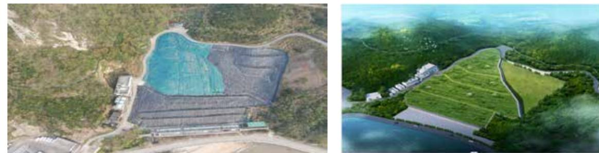
建设规模：提升改造磨石弄垃圾填埋场，包括垃圾堆体整形，封场覆盖，垂直防渗，渗滤液、填埋气体收集导排等；同步改造渗滤液厂，处理规模 70t/d，包括渗滤液生产辅助用房、储泥池和膜系统更换，并购置相关配套设备等。
