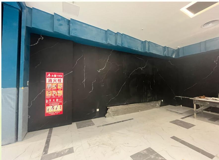
阜宁玖悦城项目从环保和降低造价的角度出发，创新性的首次在幸福蓝海影城装修中大面积采用竹木纤维板装饰。此类板材是由竹木纤维、钙粉、天然树脂等经高温挤压制成的新型板材，具有轻质、环保、抗压、抗弯等特点，并且表面花纹可订制，可以很好的替代传统装饰材料。
