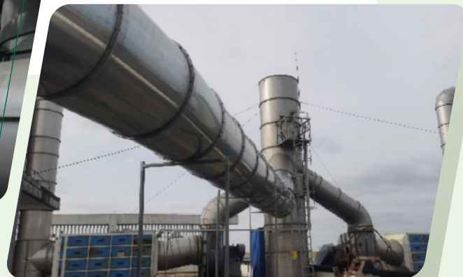
正在工作的 VOCs 废气处理设备
