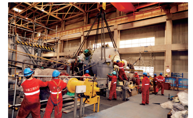
浙能电力合理安排检修计划推进机组检修
