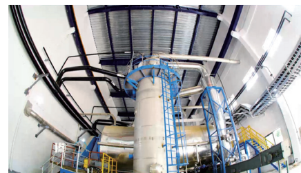
压缩空气项目建设
