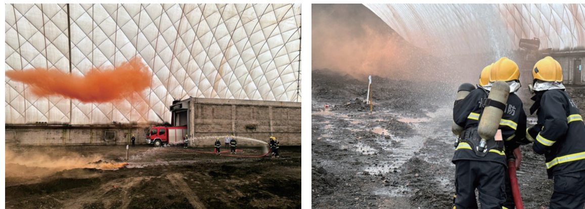
气膜煤场专项应急演练现场
