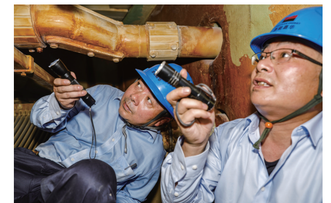
锅炉技术人员正在检查吸收塔内部
