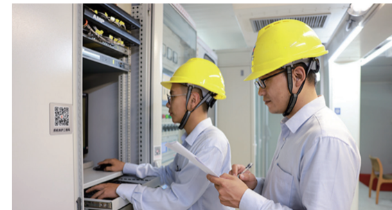
浙能金燃运行人员就地执行燃机启动操作
