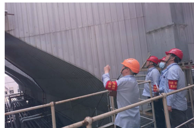
烟气余热利用改造项目现场检查
