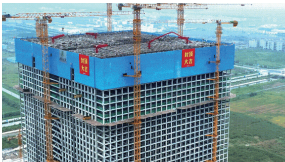
如东 100MWh 重力储能项目主体工程封顶
