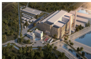
越南河内 4000 吨 / 天 垃圾焚烧发电项目
