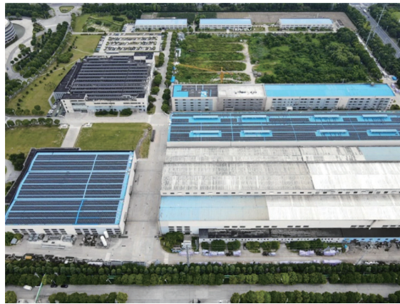
总部园区 3.1MW 屋顶分布式光伏
