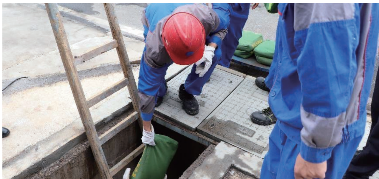
环境应急演练-堵断溢流水外流
