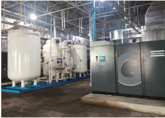
【空压制氮系统改造】
