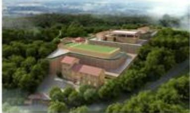
**湖北恩施·宣恩供水城乡一体化及水库建设项目** 项目涉及宣恩县城及9个乡镇，新建水厂7座、扩建水厂6座、委托运营水厂5座和新建水库1座。新建和扩建供水规模约 54200m<sup>3</sup>/d，委托运行水厂供水规模约32800m<sup>3</sup>/d，建成后将提升25万农村人口供水能力。
