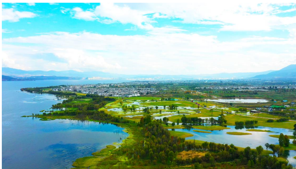
大理市洱海流域湖滨缓冲带生态修复与湿地建设项目
