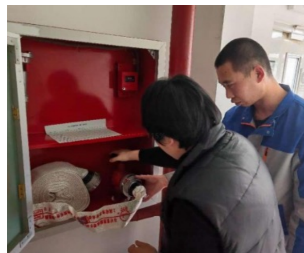
消防专项检查
