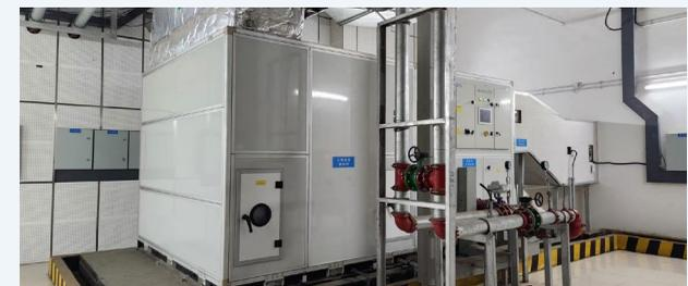
格力磁悬浮直膨式地铁车站智能通风空调系统
