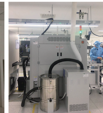
割板机设备安装除尘装置
