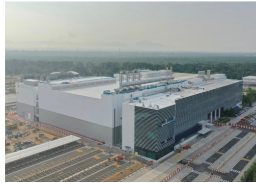
▲ 亚德马来西亚项目实景
