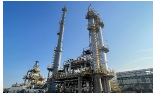
▲ 浙石化废气废液焚烧系统
