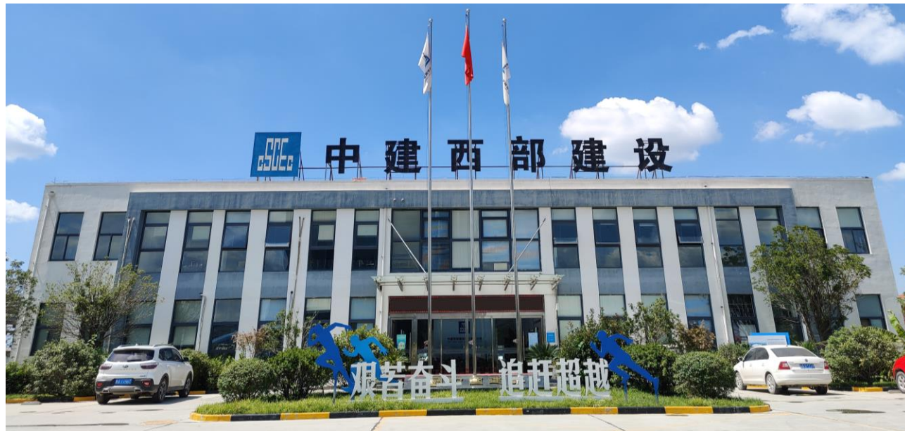
运用再生混凝土建造的办公楼
