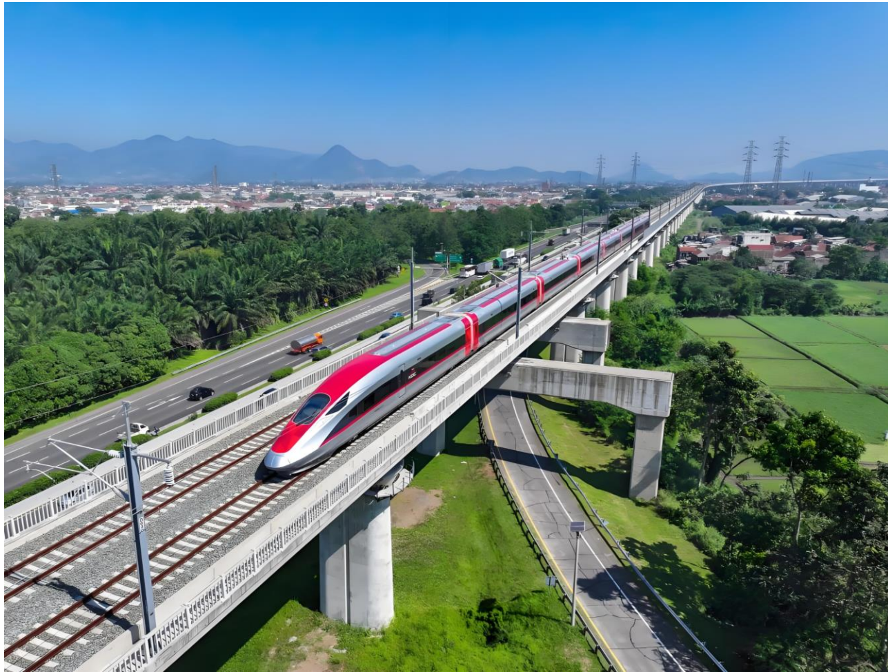
印度尼西亚雅万高铁项目
