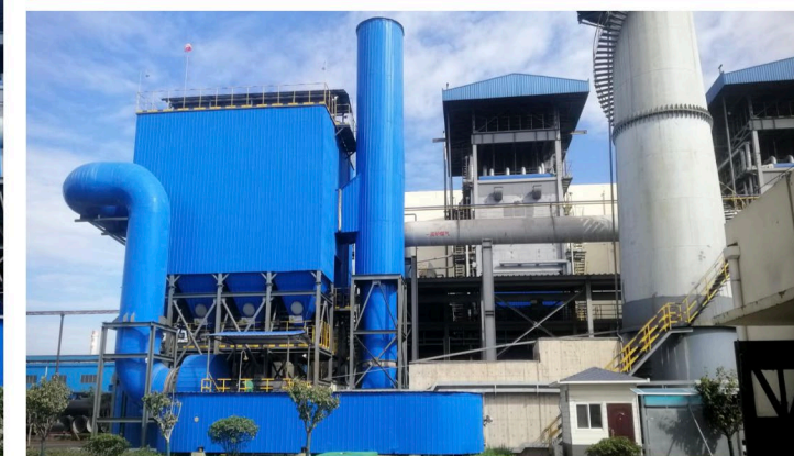
日照铸福配套热风炉烟气脱硫工程EPC总承包 项目需建设烟气脱硫工程，烟气处理技术路线与规模：采用干法脱硫+脱硫后布袋除尘技术，经烟气干法脱硫系统处理后的烟气排放指标符合当地标准
