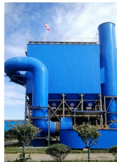
日照铸福配套热风炉烟气脱硫工程EPC总承包 项目需建设烟气脱硫工程，烟气处理技术路线与规模：采用干法脱硫+脱硫后布袋除尘技术，经烟气干法脱硫系统处理后的烟气排放指标符合当地标准
