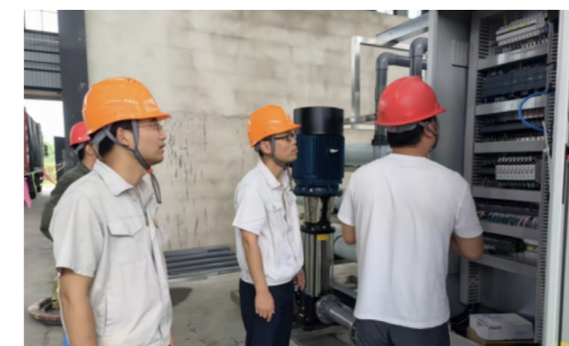
“电池级四氧化三锰项目”现场施工情况
