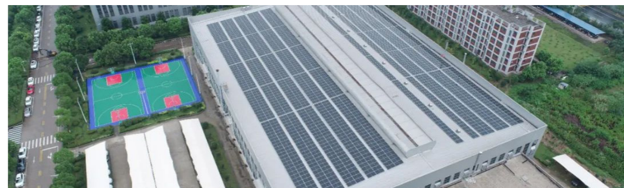
中钢天源第一期分布式光伏项目
