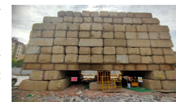
南京至马鞍山城际铁路工程
