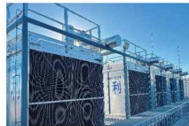
冷却塔设备更新
